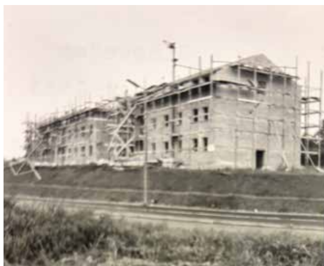
Det store byggeri af Ringparken under opførelse i 1965-66
